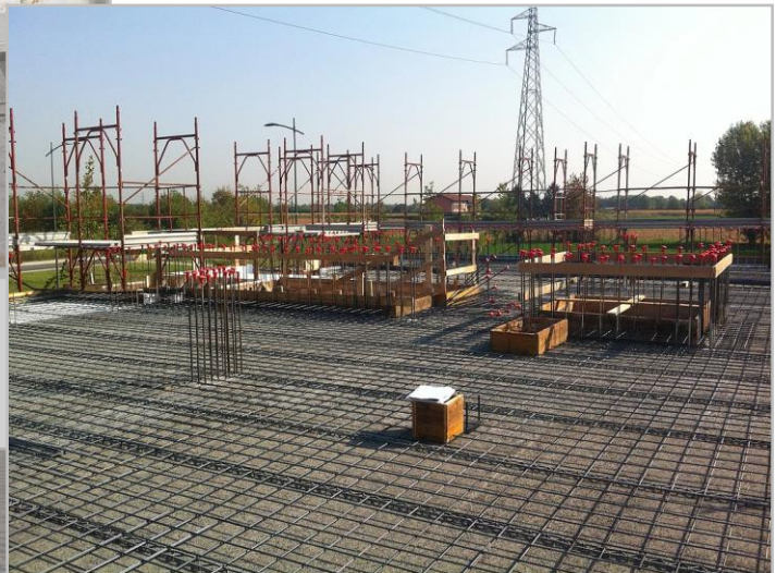
Dettaglio solai in getto pieno
