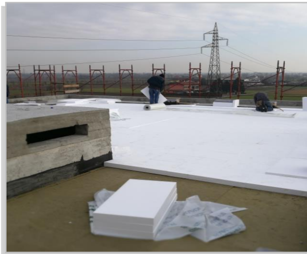
Dettaglio coibentazione copertura
