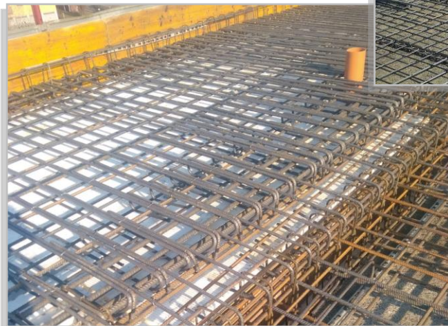
Dettaglio armatura solaio
